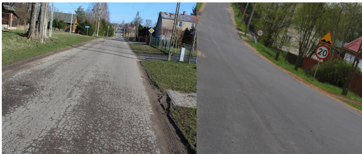
Zdjęcie: remont drogi powiatowej nr 1619B od miejscowości Nowoberezowo - Nowokornino - Trywieża - obręb skrzyżowania od miejscowości Rzepiska
