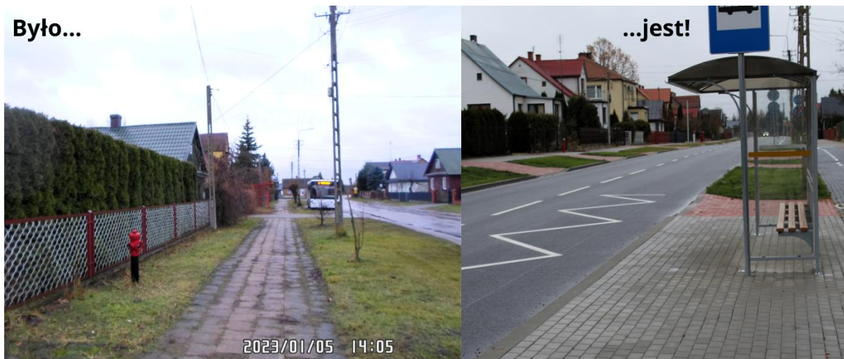
Zdjęcie: efekty rozbudowy i przebudowy ul. Górnej (dr. powiatowa nr 2323B ) w Hajnówce II etap
