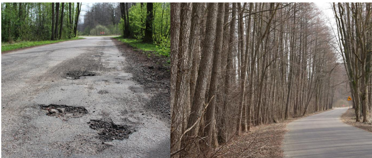
Efekty modernizacji dróg powiatowych w Gminie Białowieża
