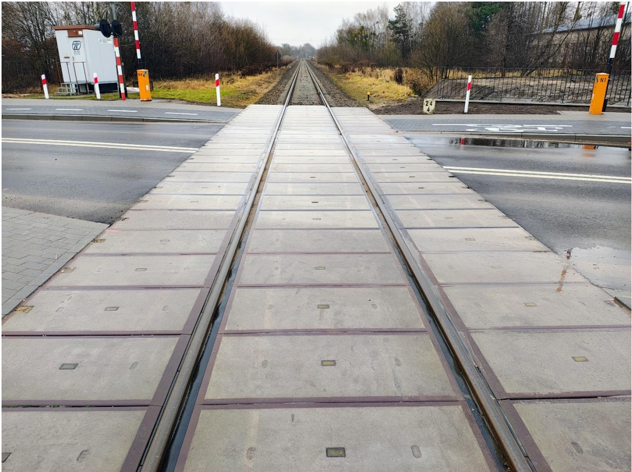
Przebudowa ul. Górnej w Hajnówce
